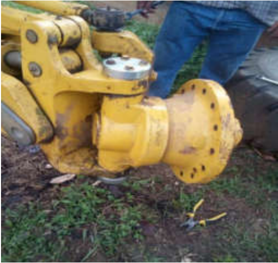
Reparacion de King-pin motoniveladora
